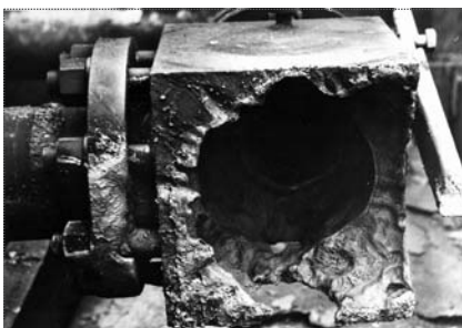
Рис. 2. Общий вид клапана T268 — объекта испытаний после его возгорания
